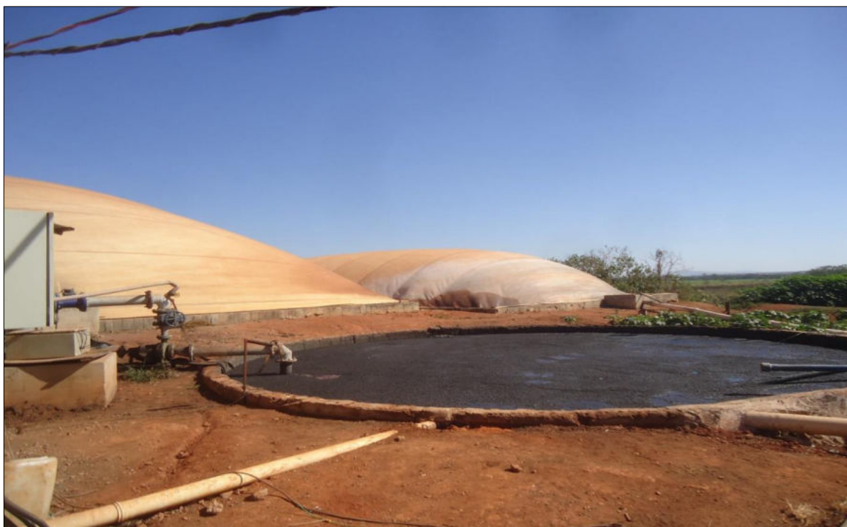
Figura 19. Vista do equalizador do sistema de tratamento de dejetos da Fazenda Guará.
