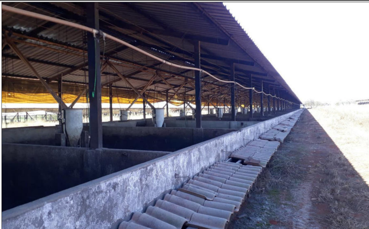
Figura 18. Vista das canaletas na granja de suínos da Fazenda Guará.
