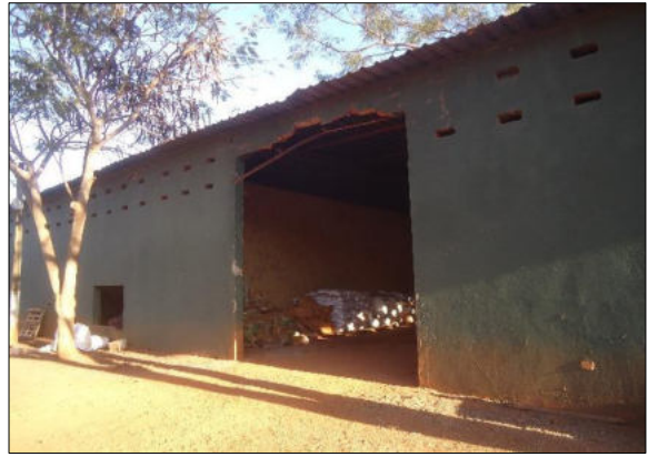
Foto 6 – Galpão de armazenamento de adubos e sementes.
