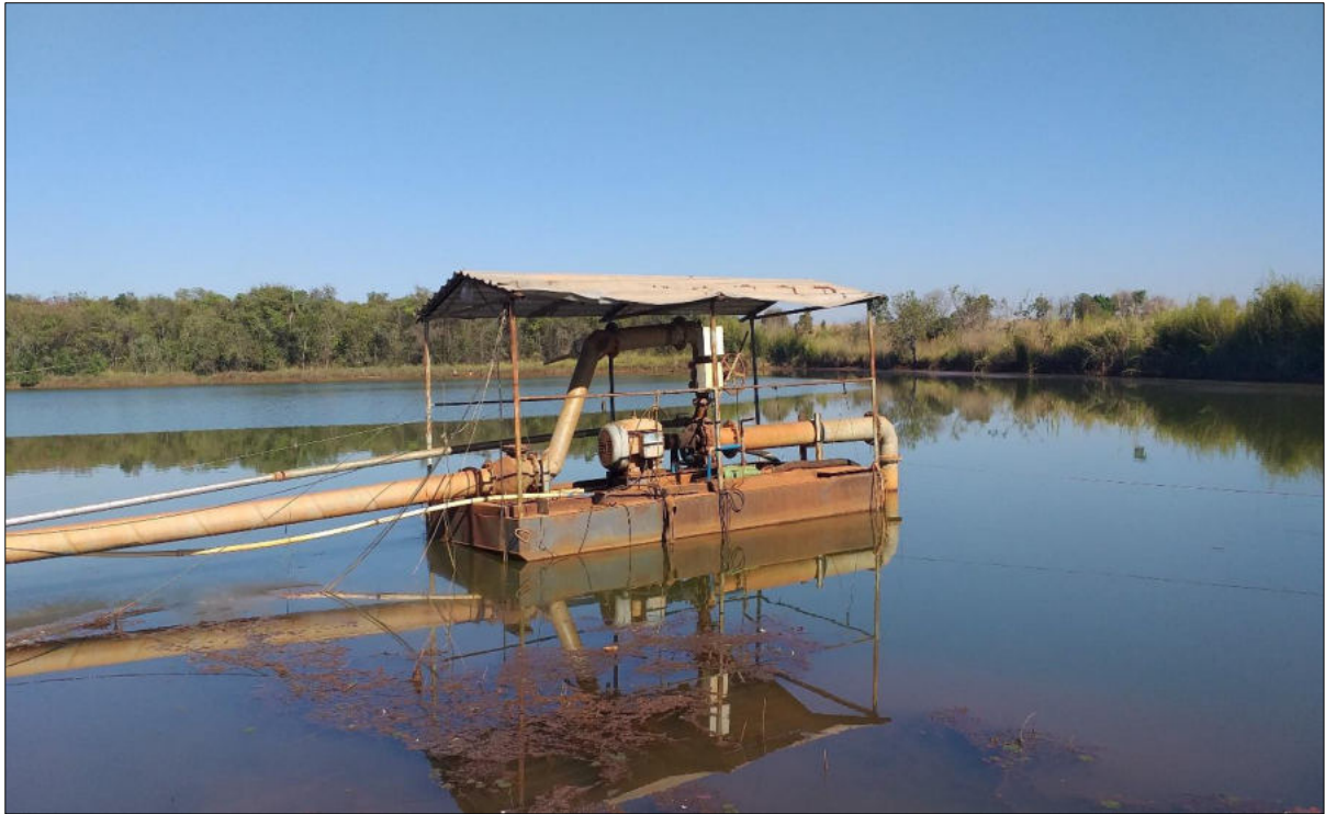
Figura 4. Ponto de captação de água na Fazenda Guará.
