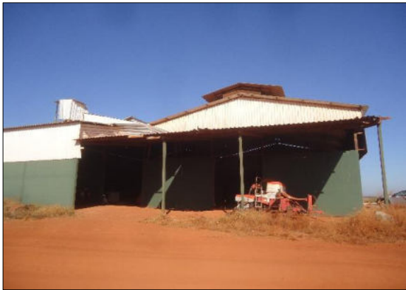
Foto 9 - Galpão de máquinas.
