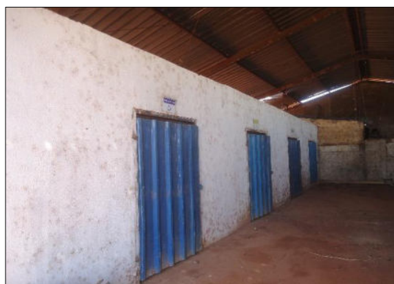
Foto 16 – Depósito de resíduos sólidos.
