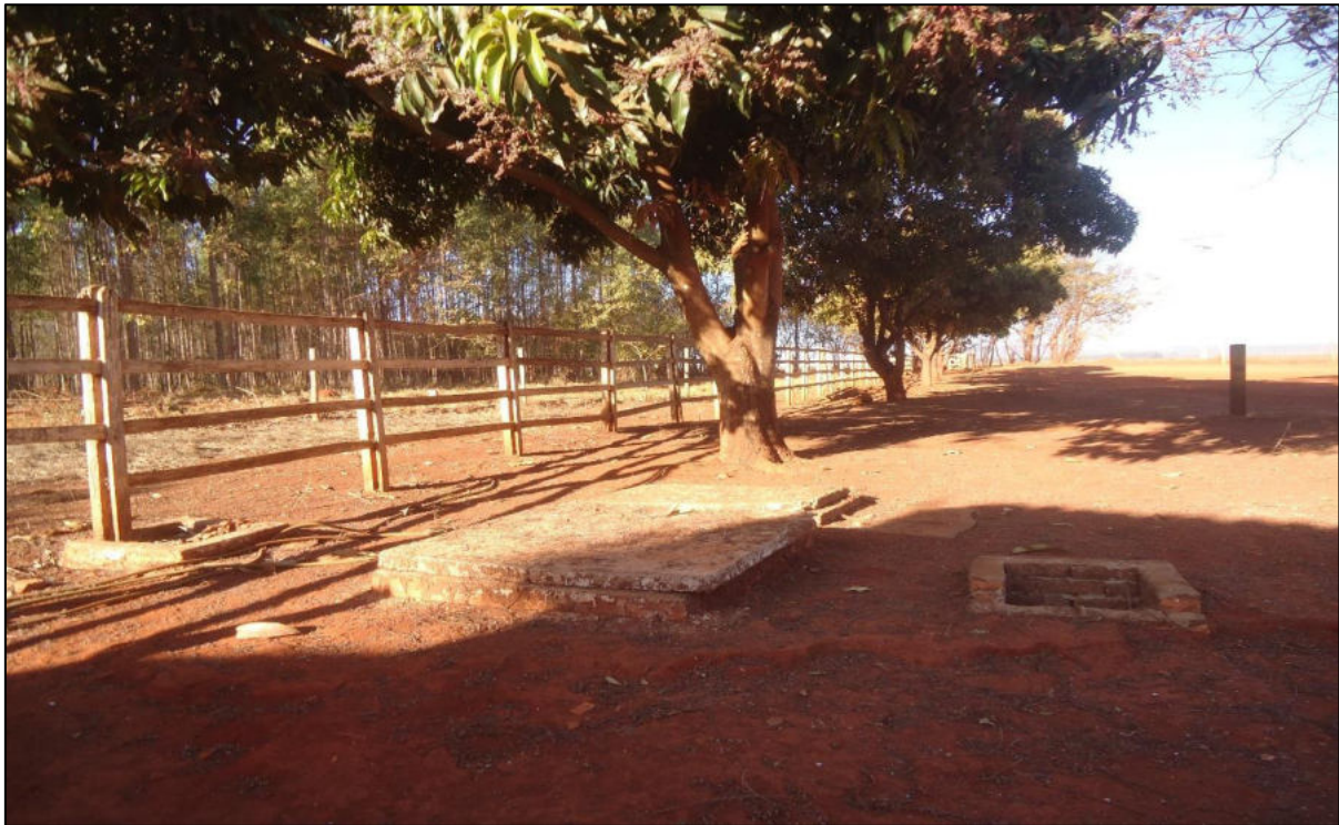
Figura 280. Fossa séptica do escritório instalado na Fazenda Guará.
