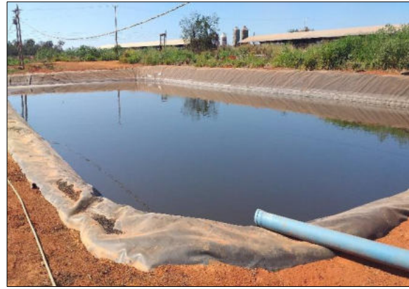
Figura 21. Lagoa 2 do sistema de tratamento de dejetos.
