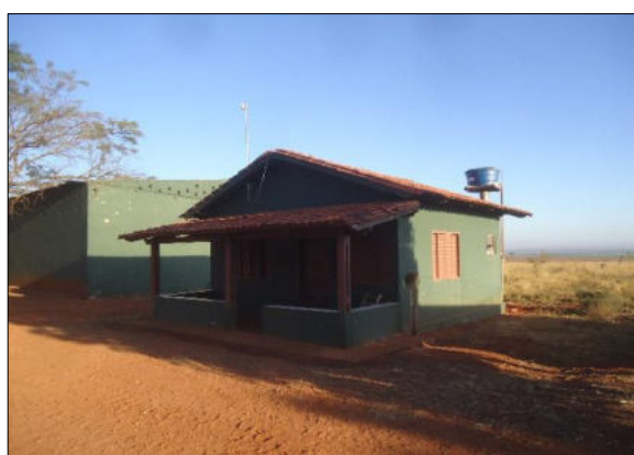
Foto 3 – Residência dos funcionários.
