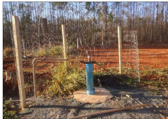
Figura 6. Poço a ser outorgado próximo à sede da Fazenda Guará.
