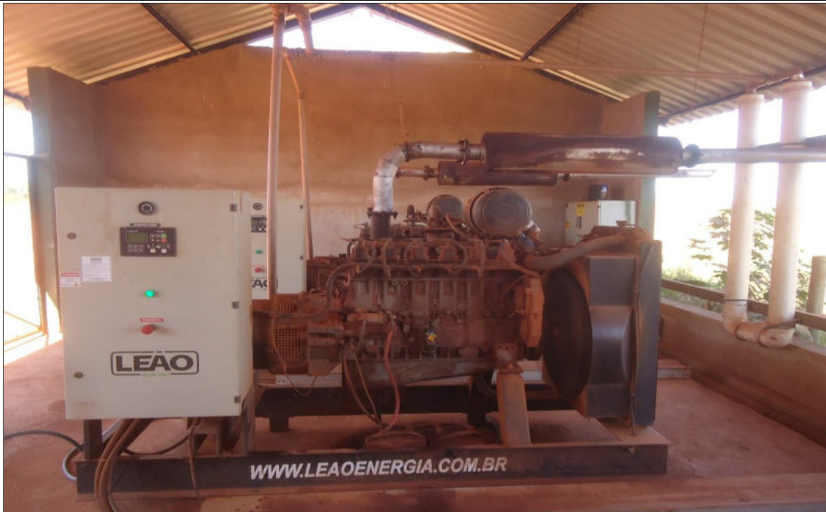
Figura 31. Gerador de energia a partir do biogás presente na Fazenda Guará.
