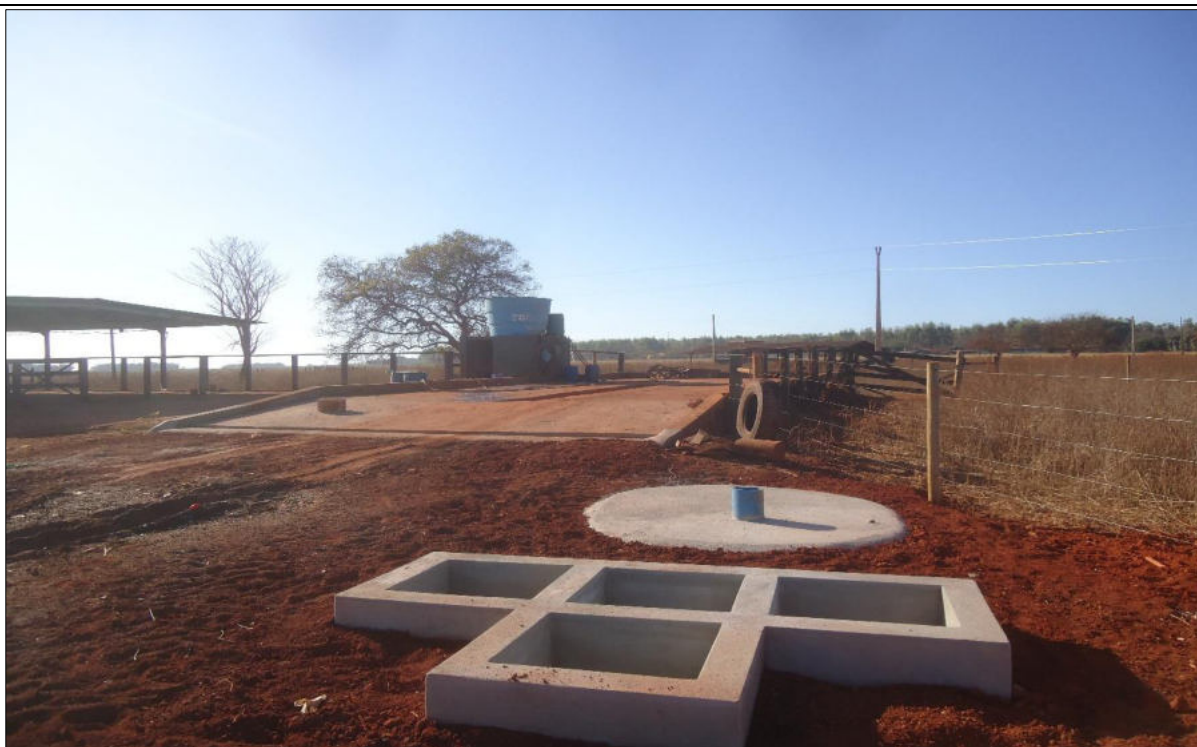
Figura 36. Vista geral de um dos lavadores da Fazenda Guar.
