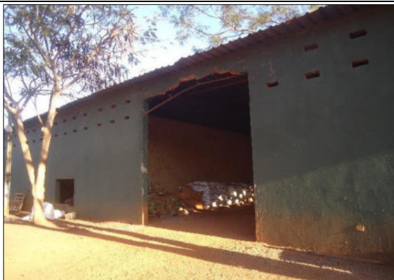
Figura 37. Vista geral do depósito de adubos e sementes na Fazenda Guará.
