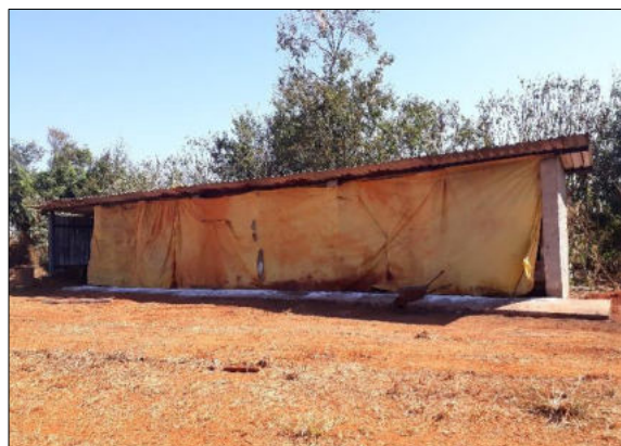
Figura 17. Vista geral da composteira 2 da Fazenda Guar4.
