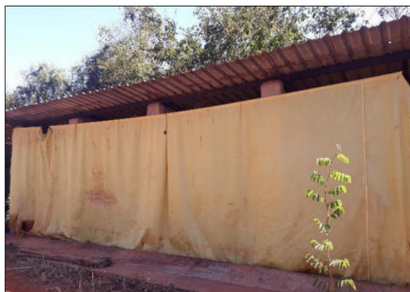
Figura 16. Vista geral da composteira 1 da Fazenda Guar4.
