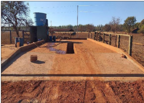
Foto 7 - Lavador de máquinas e equipamentos.
