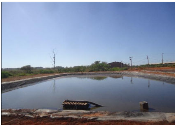
Foto 11 – Lagoa de resíduos.
