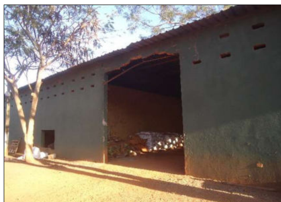
Foto 6 – Galpão de armazenamento de adubos e sementes.
