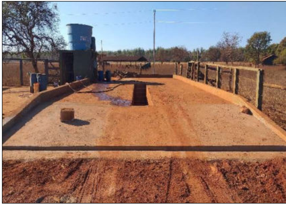
Foto 7 - Lavador de máquinas e equipamentos.
