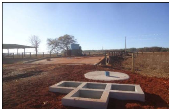
Figura 30. Vista geral do lavador da Fazenda Guará.
