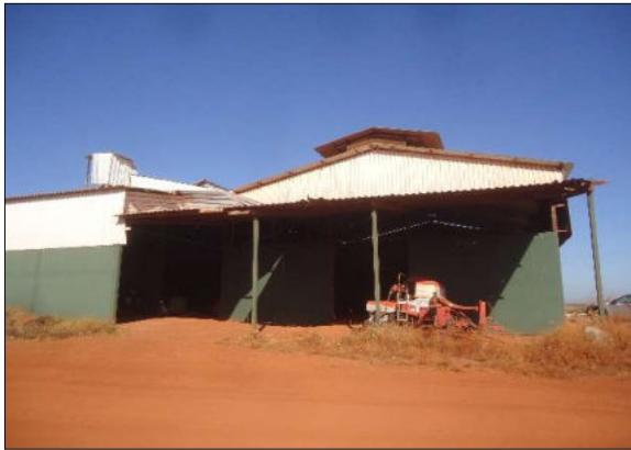
Foto 9 - Galpão de máquinas.
