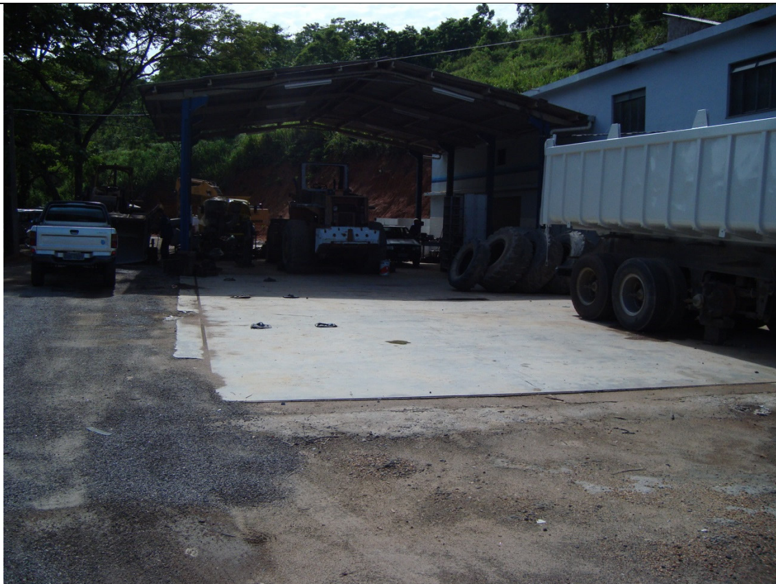
Figura 14. Oficina existente na Pedreira São Geraldo.
