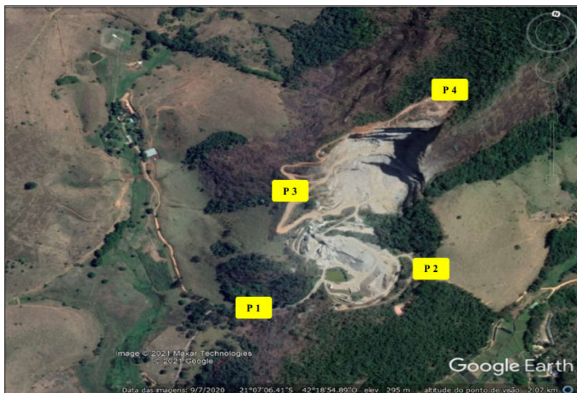
Figura 138. Localização dos pontos de medição de níveis de ruídos.
