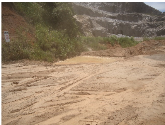
Figura 128. Bacia de contenção nas vias de acesso da lavra
