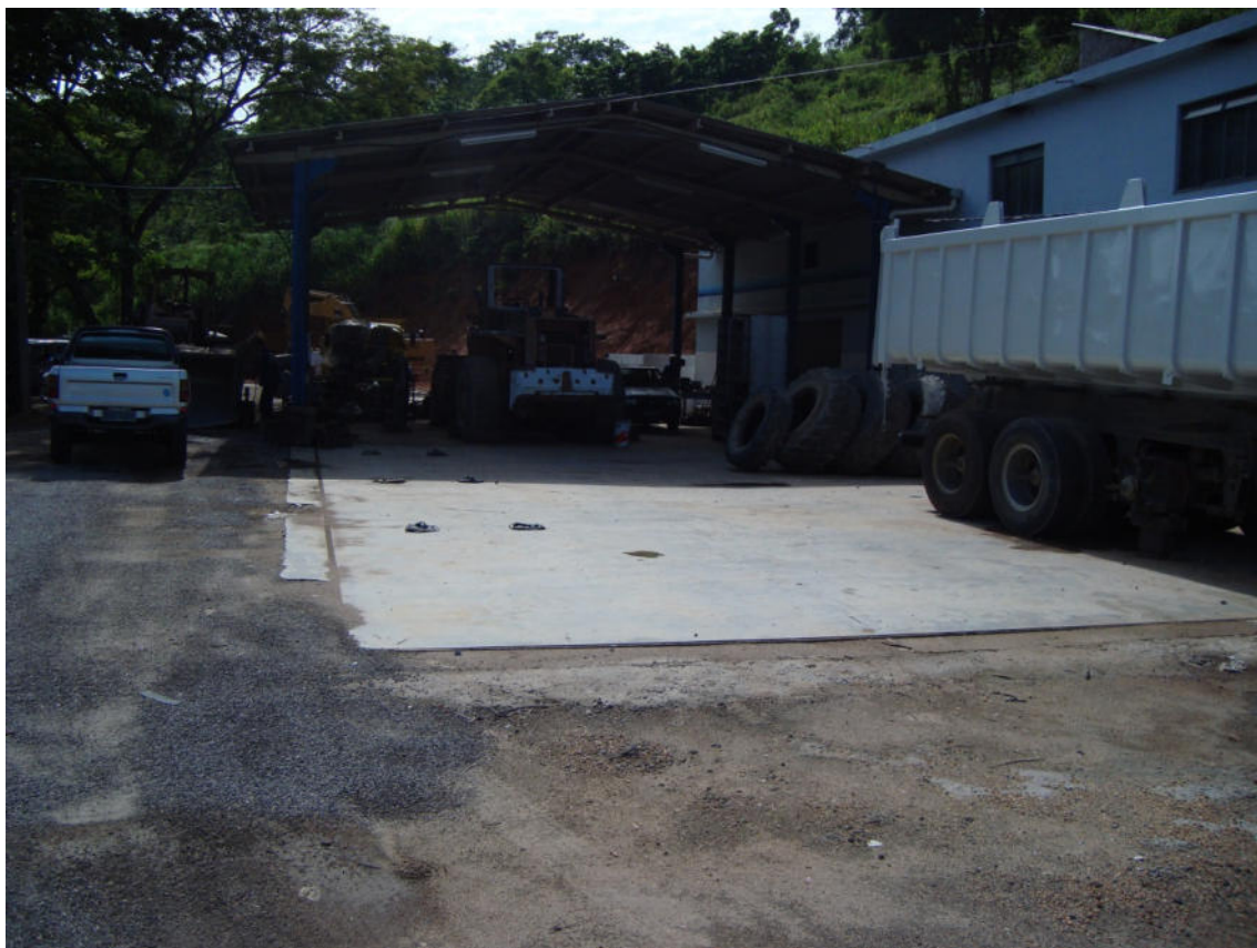
Figura 12. Oficina existente na Pedreira São Geraldo.
