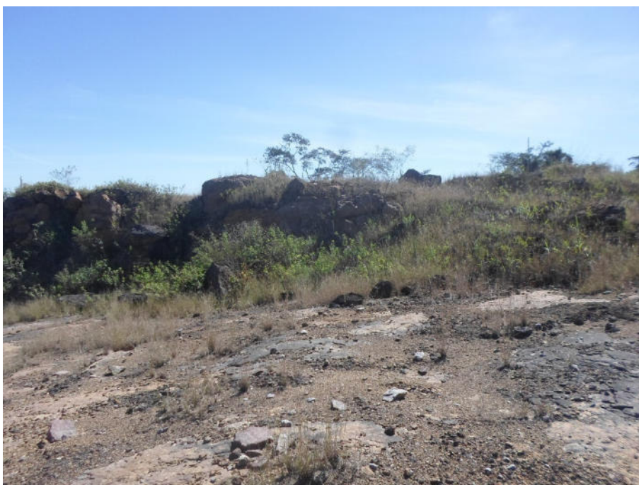
Figura 23. Aspecto do maciço rochoso na área de avanço da frente de lavra
