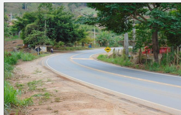
Figura 91. Rodovia MG-111 na região do Córrego do Barreiro.
