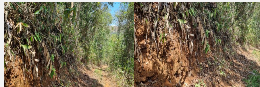
Figura 60. Ponto de caminhada 10 (E 188844.30, N 7766123.43 – Elevação 734 m).
