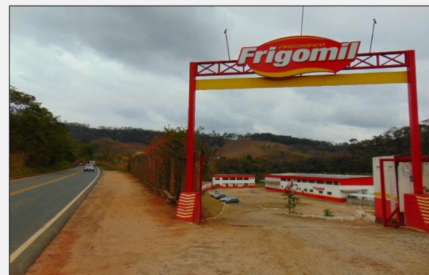
Figura 95. Frigorífico Frigomil, na região do Córrego do Barreiro, às margens da MG-111.
