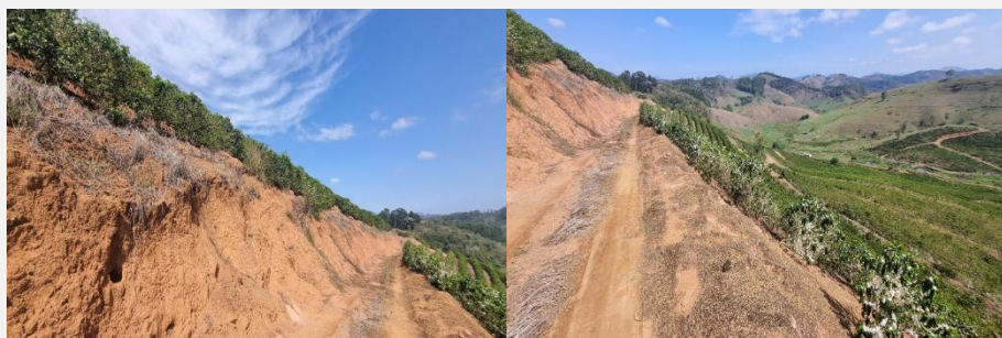
Figura 61. Ponto de caminhada 11 (E 188571.72, N 7766066.68 – Elevação 708 m).
